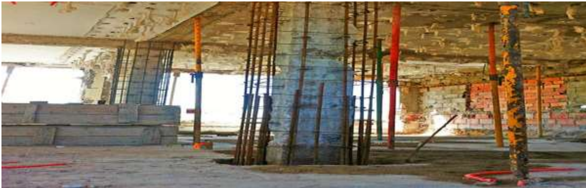
(شكل 17) تدعيم الأعمدة للدور العلوي
