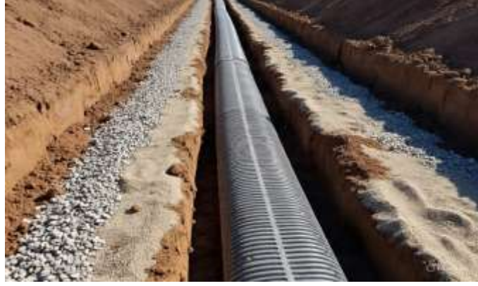
( شكل 7 ) تركيب ووضع الأنابيب
