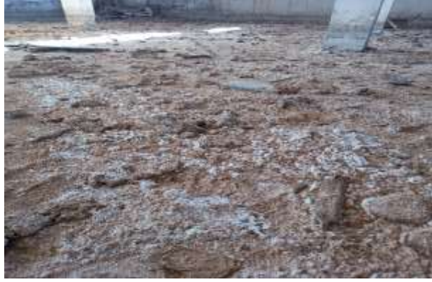
شكل (3) تظهر الصورة وجود طبقة بيضاء سميكة بأرضية البدروم
