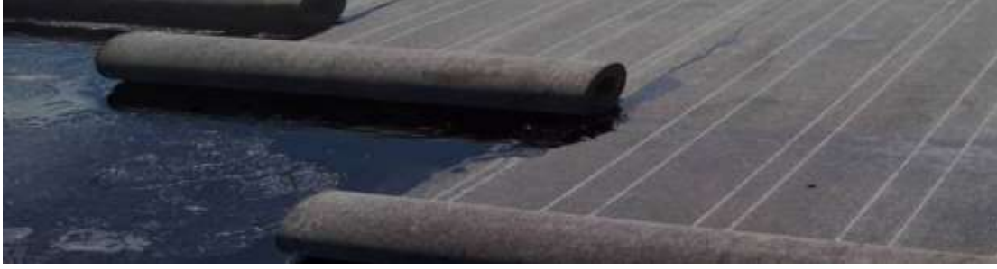
(شكل 14) صفائح مرنة للعزل المائي البيتومين والبلاستيك
